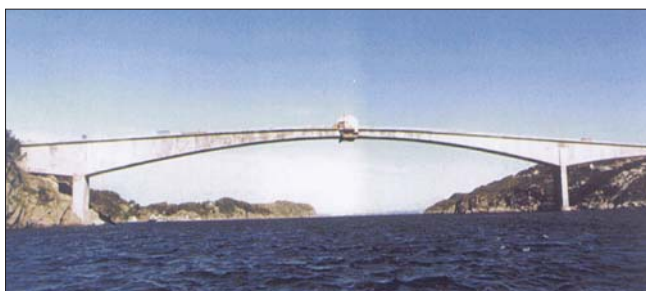
Рис. 4. Мост Stolma (Норвегия). Построен в 1998 г. (главный пролет 301 м). Центральная часть пролета длиной 184 м и опоры моста выполнены из высокопрочного (класс по прочности на сжатие LC55 марки по средней плотности D1900) конструкционного легкого бетона с использованием в качестве крупного пористого заполнителя HF Leca 800 – типа керамзитового гравия
