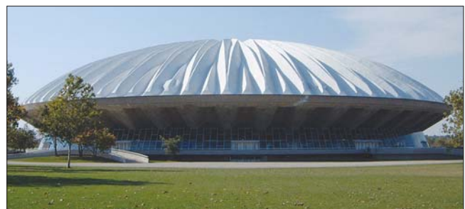
Рис. 15. Складчатое оболочечное покрытие здания «Assembly Hall» Иллинойского университета. 24 изогнутых сегментных пластины из легкого бетона класса LC20 на заполнителях из вспученных глинистых сланцев (lyonit) марки по средней плотности D1700 связаны предварительно напряженной кольцевой балкой (внешний диаметр 122 м, внутренний – 6,5 м)
