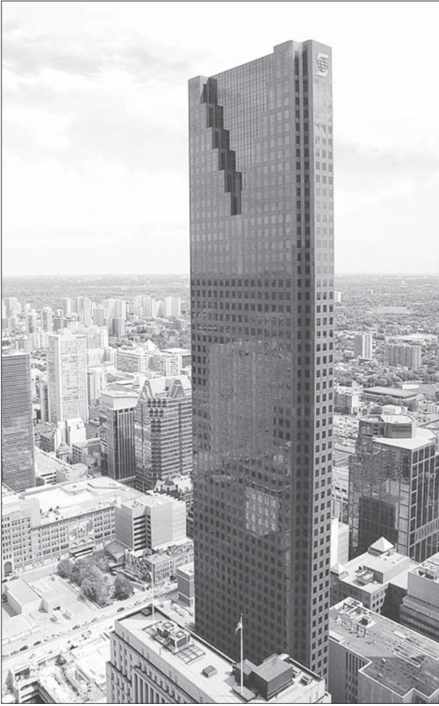
Рис. 7. Здание «Scotia Plaza Tower» (69 этажей, 276 м) в финансовом районе г. Торонто (Канада). Перекрытия высокой огнестойкости (класс K_0 при \tau_{огн}=2 ч) выполнены из монолитного легкого бетона класса по прочности LC30–LC40 марки по плотности D1800–D1900 на основе пористого шлакового гравия (pelletized slag) с использованием шлаковых цементах (типа «blended cements»-ASTM, 1990 г.)
