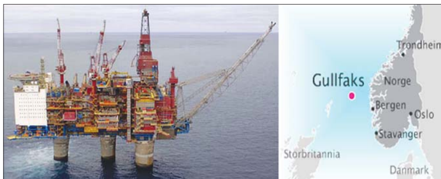
Рис. 12. Платформа для добычи нефти «Gullfaks» массой 1,5 млн т. Надводная часть платформы и завод с системой мощных насосов для перекачки нефти построена в норвежском порту Stavanger и затем флотирована к месту строительства платформы «Gullfaks oil field» в Норвежском море
