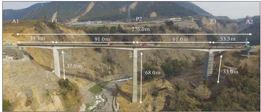
Рис. 10. Вид на мост Асо Чойо Охаси во время его восстановления после землетрясения Fig. 10. View of the Aso Choyo-Ohashi Bridge during its reconstruction after the earthquake
