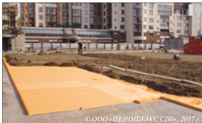
Рис. 2. Примеры использования теплоизоляции ПЕНОПЛЭКС® при строительстве эксплуатируемых покрытий
