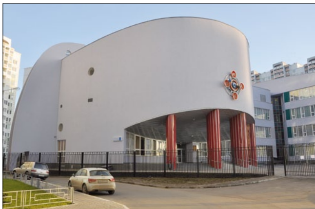
Рис. 9. Главный вход в школу
