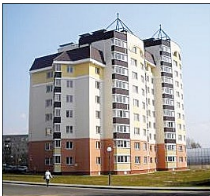
Рис. 4. Фасад 69-квартирного энергоэффективного дома (г. Гродно)
