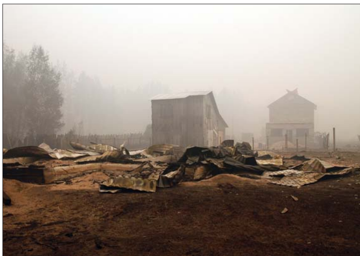
30 июля 2010 г., с. Передельцы Рязанского района Рязанской области. Село сгорело полностью, уцелели только два дома, построенные из керамзитобетонных блоков
