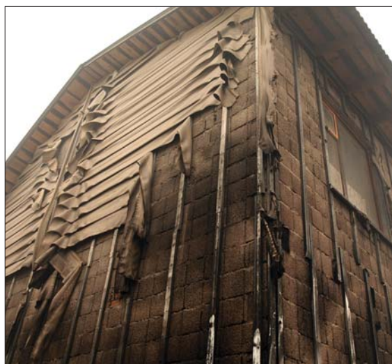
30 июля 2010 г., с. Передельцы Рязанского района Рязанской области. Село сгорело полностью, уцелели только два дома, построенные из керамзитобетонных блоков
