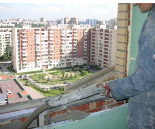
Утепление стены в многоэтажном здании
