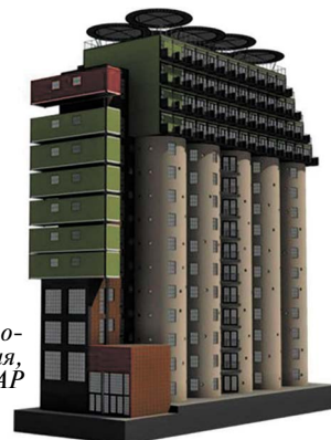
Рис. 7. Надстройка элеватора грузовыми контейнерами, г. Иоханнесбург, ЮАР
