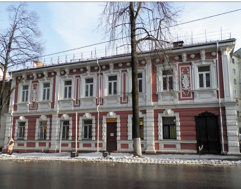
Рис. 1. Жилой дом на ул. Малой Покровской. Общий вид после реставрации. Фото 2017 г.
