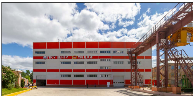
«198 КЖИ», здание нового цеха
