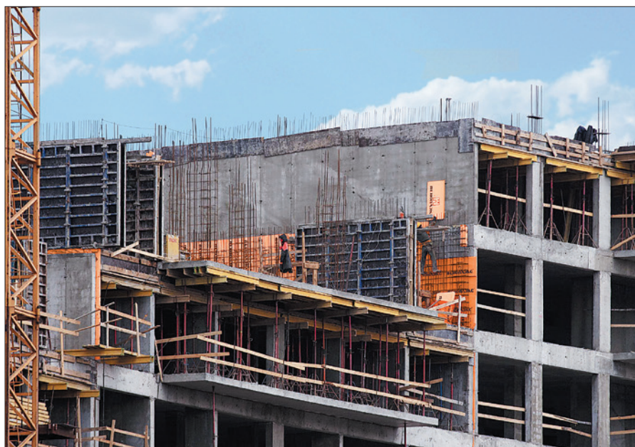
ЖК «Три ветра», Санкт-Петербург. Пример применения ПЕНОПЛЭКС® в системе деформационных швов
