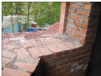
Рис. 3. Движение солей изнутри на наружную поверхность кладки через растворный шов
