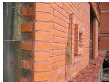
Рис. 3. Движение солей изнутри на наружную поверхность кладки через растворный шов
