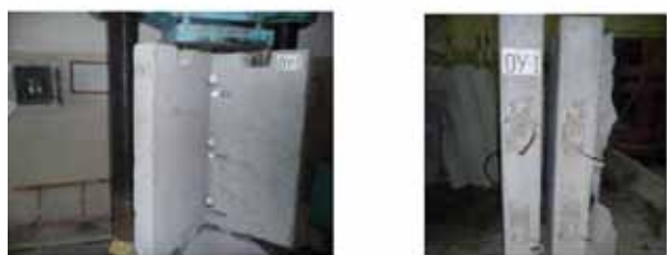
Разрушение Г-образного стыка
