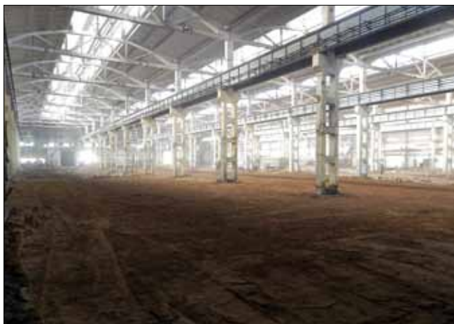
Рис. 7. Подготовка старого цеха к монтажу нового оборудования
