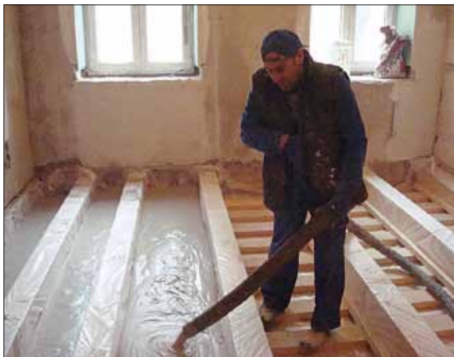
Рис. 4. Утепление перекрытий
