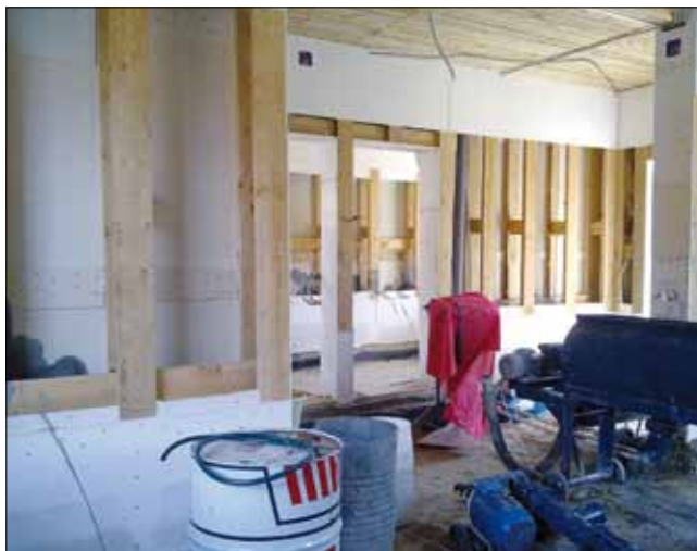
Рис. 5. Каркас коттеджа
