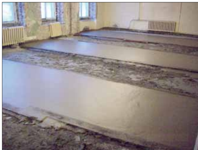
Рис. 3. Заливка пенобетона происходит секторами
