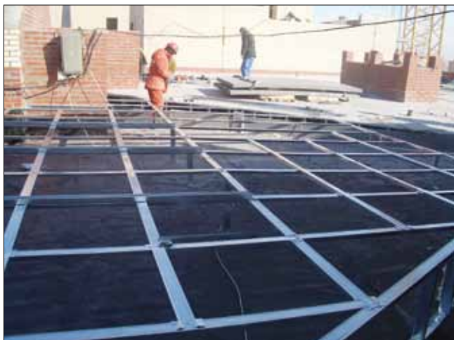
Рис. 2. Каркас кровли
