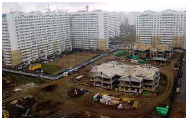
Рис. 2. Общий вид застройки 16-этажными жилыми домами серии 135с
