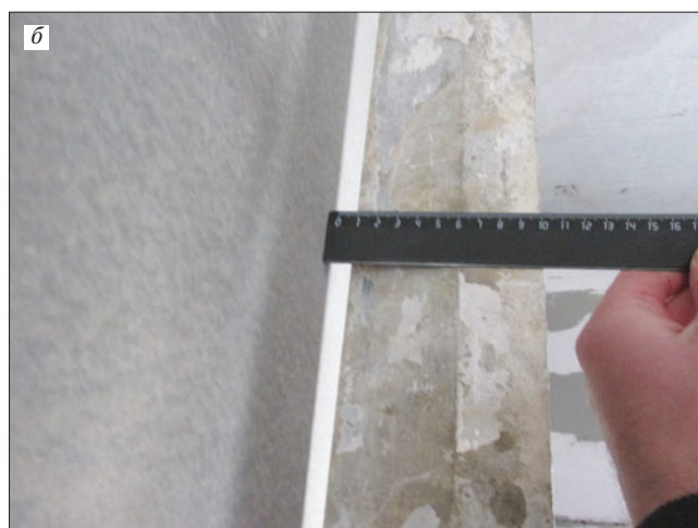
Рис. 1. Инструментальные измерения образовавшихся дефектов: а – сквозная трещина в щите опалубки; б – выпуклость вертикальной конструкции
