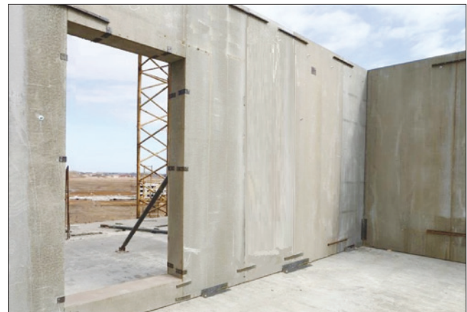
Рис. 3. Несъемная опалубка в рабочем положении
