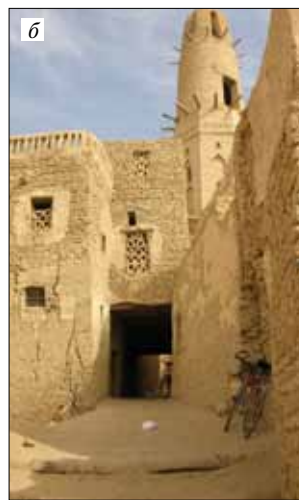
Рис. 5. Средневековый город в Ливийской пустыне, в оазисе Дахла, Египет. Город практически полностью построен из сырцового кирпича. Перекрытия сооружены из пальмовых стволов (а); средневековый дом в Каср-эль-Дахла (б)
