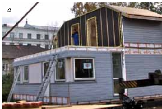
Рис. 3. Монтаж модулей первого этажа экспериментального здания (а); по периметру одной из стыкуемых стен и перекрытий, а также существенных проемов закреплен утеплитель в виде жгута для исключения теплопотерь при эксплуатации [1] (б)
