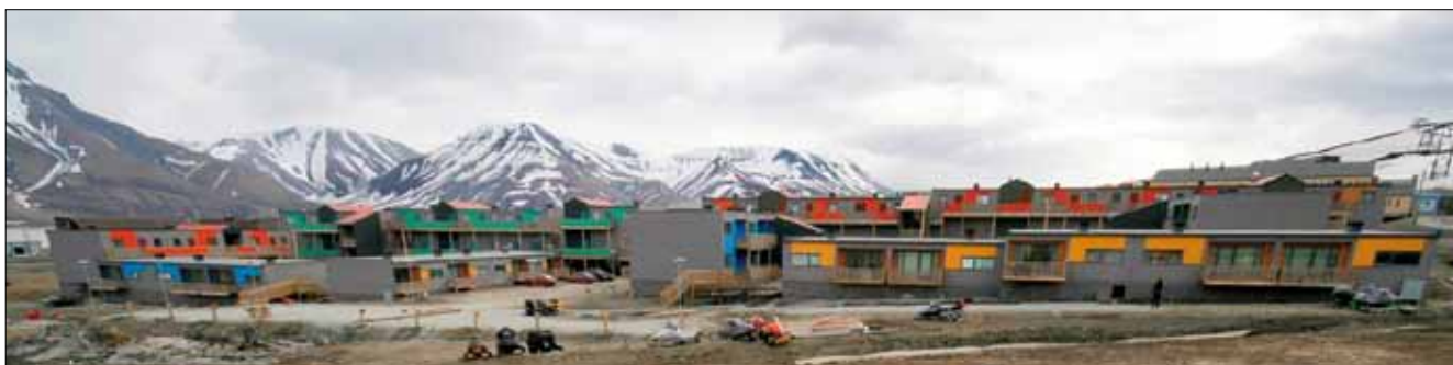
Рис. 1. Жилой комплекс из малоэтажных модульных зданий на о. Шпицберген, Норвегия (Hålogaland Element)
