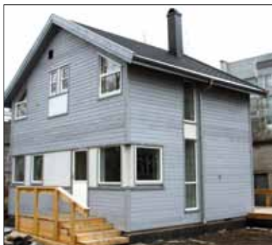
Рис. 2. Экспериментальное деревянное модульное здание натуральных размеров в г. Архангельске
