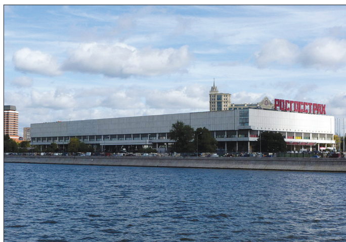
Рис. 5. Демонтаж рекламной конструкции
