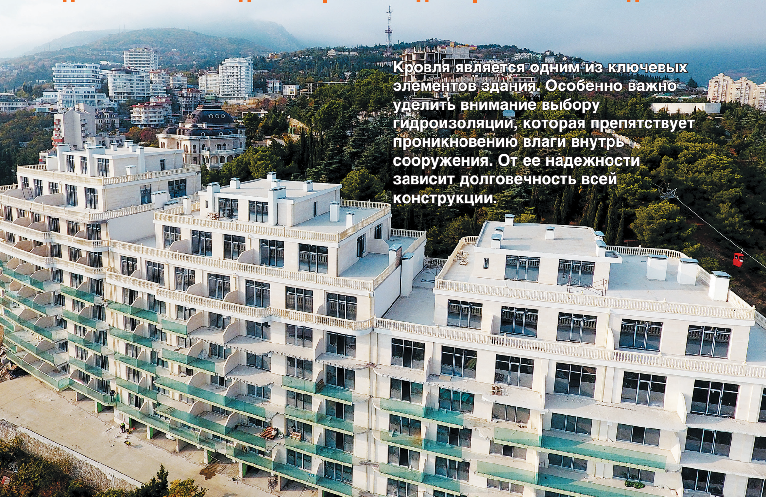
Гидроизоляция PLASTFOIL® на крыше ЖК Холм Славы, Республика Крым, г. Ялта. 2017 г.
