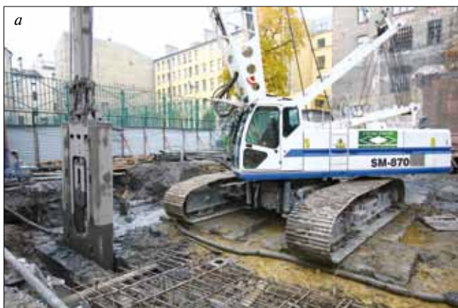
Рис. 5. Подземные работы на объекте в Санкт-Петербурге (ул. Правды, 10): а – грейферная установка для устройства «стены в грунте»; б – распорная конструкция для удержания стен котлована
