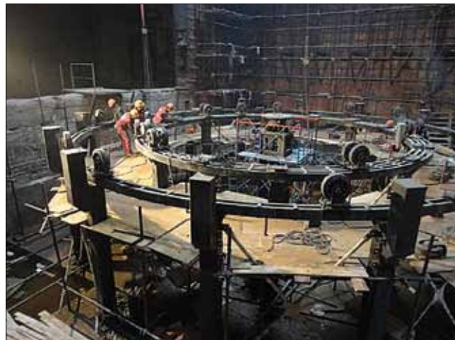
Рис. 9. Монтаж поворотного механизма сцены в заглубленном подземном пространстве
