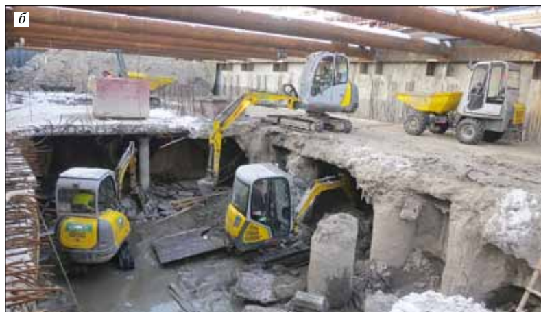
Рис. 6. Устройство подземной части здания Арбитражного суда (ул. Смольного, 6): а – грейферное оборудование для устройства «стены в грунте»; б – откопка котлована методом top-down
