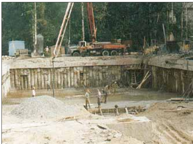
Рис. 1. Подземный гараж вблизи уже построенных домов (1994 г., Санкт-Петербург, ул. Пархоменко, 14)
