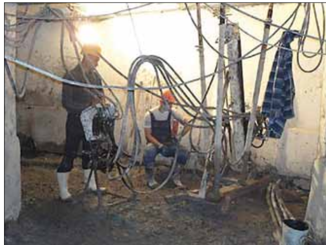
Рис. 8. Усиление существующих фундаментов буронабейно-цементными сваями
