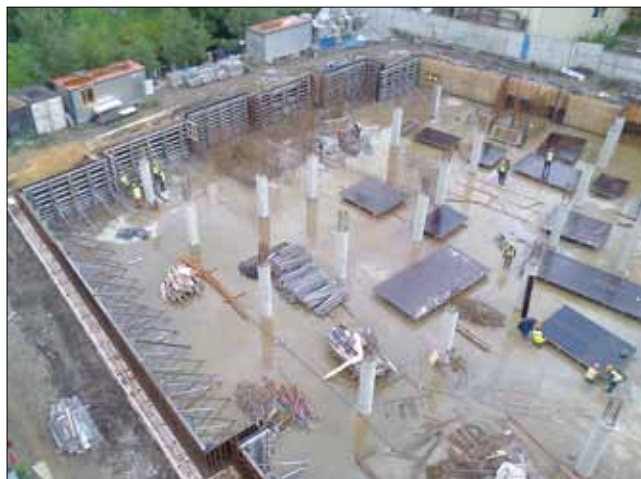
Рис. 2. Комплекс работ нулевого цикла по строительству подземного паркинга кинотеатра «Великан»: устройство ограждающей конструкции по технологии «стена в грунте», свайного поля по технологии «SOB-колонна», откопка котлована и устройство железобетонных монолитных конструкций
