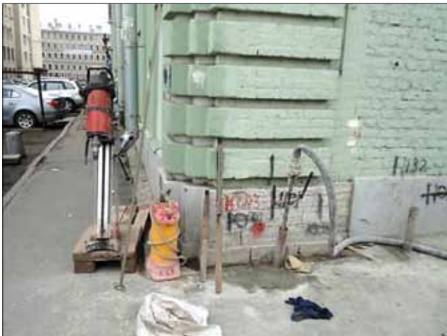
Рис. 7. Усиление тела фундамента и контактной зоны методом цементации
