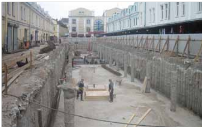
Рис. 4. Устройство «стены в грунте» из буросекущихся свай на объекте Апраксин двор
