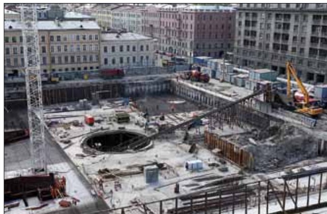
Рис. 4. Производство работ методом top-down на строительстве второй сцены Мариинского театра
