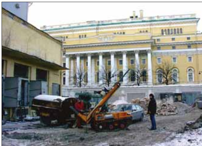
Рис. 1. Исследовательские работы по изучению влияния новых свайных технологий на напряженно-деформированное состояние грунтового массива
