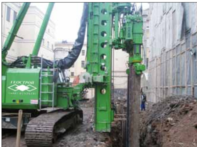
Рис. 7. Строительство подземного паркинга: ограждающая конструкция из металлического z-образного шпунта методом вдавливания (Невский пр., 55)
