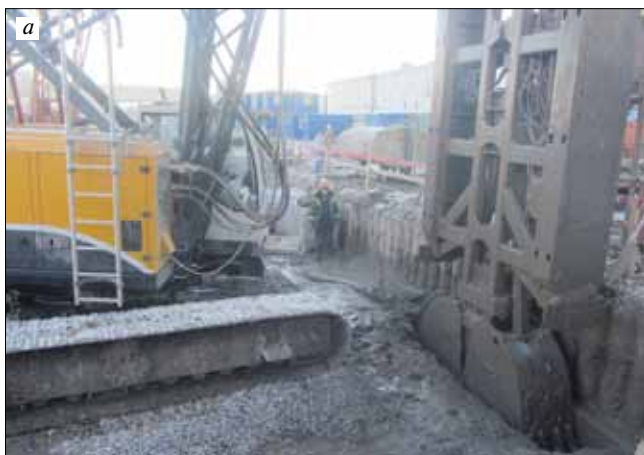
Рис. 6. Устройство подземной части здания Арбитражного суда (ул. Смольного, 6): а – грейферное оборудование для устройства «стены в грунте»; б – откопка котлована методом top-down
