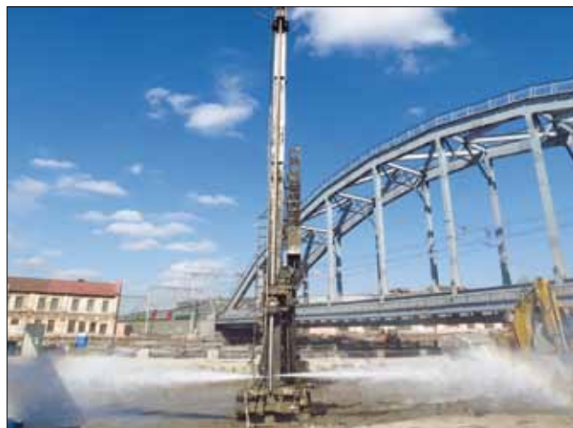
Рис. 8. Устройство противодиффузионных завес. Укрепление основания проезжей части набережной Обводного канала по технологии jet grouting
