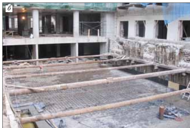
Рис. 5. Подземные работы на объекте в Санкт-Петербурге (ул. Правды, 10): а – грейферная установка для устройства «стены в грунте»; б – распорная конструкция для удержания стен котлована
