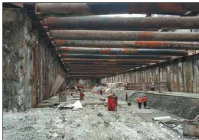
Рис. 7. Общий вид сухого котлована после экскавации Fig. 7. General view of the dry pit after excavation
