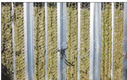
Рис. 3. Пример монтажа опалубки Fig. 3. An example of a formwork Assembly
