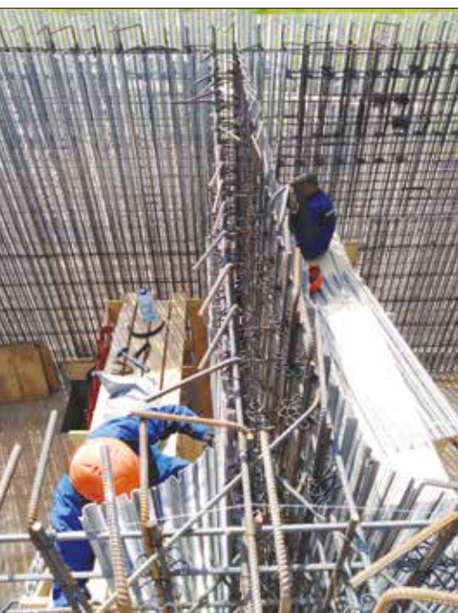
Рис. 5. Вязка опалубки к арматурному каркасу
