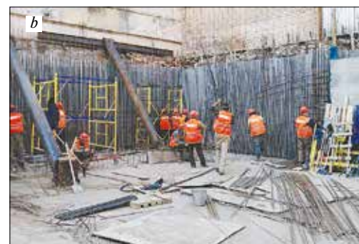
Рис. 4. Разгрузка (a) и монтаж (b) опалубки вручную Fig. 4. Unloading (a) and installing (b) the formwork manually
