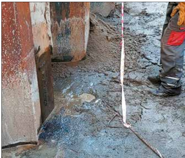
Рис. 1. Разжижение связного грунта вблизи шпунтовых свай при их виброизвлечении Fig. 1. Liquefaction of cohesive soil during vibratory sheet pile extraction
