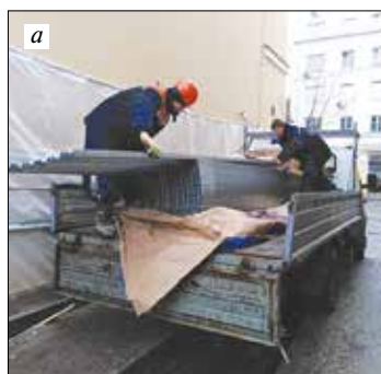
Рис. 4. Разгрузка (a) и монтаж (b) опалубки вручную Fig. 4. Unloading (a) and installing (b) the formwork manually
