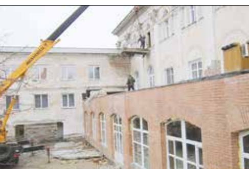
Рис. 2. Замена простенка левого крыла главного корпуса, устройство мембранной кровли и вид объекта после окончательного завершения работ и отделки Fig. 2. Replacement of the partition wall of the left wing of the main building, arrangement of the membrane roof and the view of the object after the final completion of work and finishing
