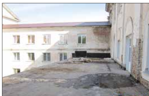
Рис. 2. Замена простенка левого крыла главного корпуса, устройство мембранной кровли и вид объекта после окончательного завершения работ и отделки Fig. 2. Replacement of the partition wall of the left wing of the main building, arrangement of the membrane roof and the view of the object after the final completion of work and finishing
