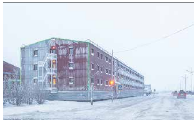
Рис. 3. Общий вид жилого здания на вечной мерзлоте с проветриваемым подпольем обычной конструкции по схеме рис. 1, закрытом большими щитами (дизайн второго типа)
