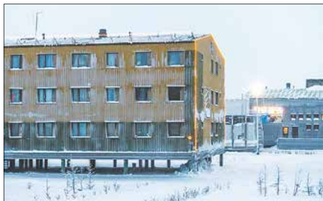
Рис. 2. Общий вид жилого здания на вечной мерзлоте с проветриваемым подпольем обычной конструкции по схеме рис. 1 (дизайн второго типа)
