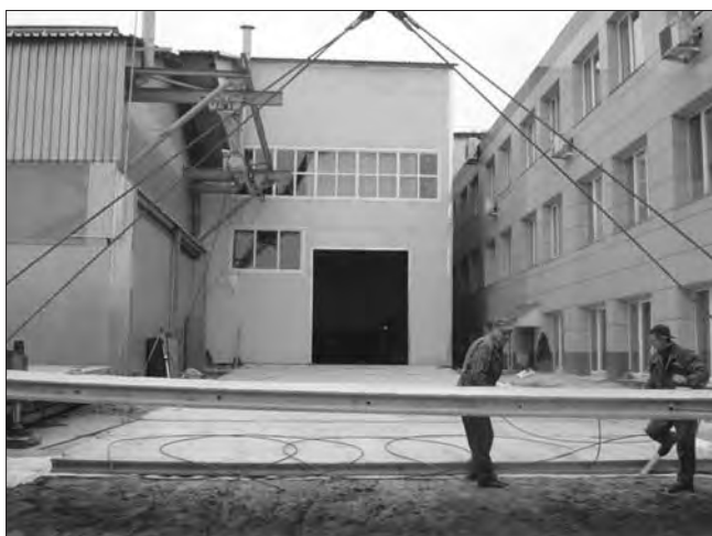
Строительство дороги по технологии СМК индустриальным способом
