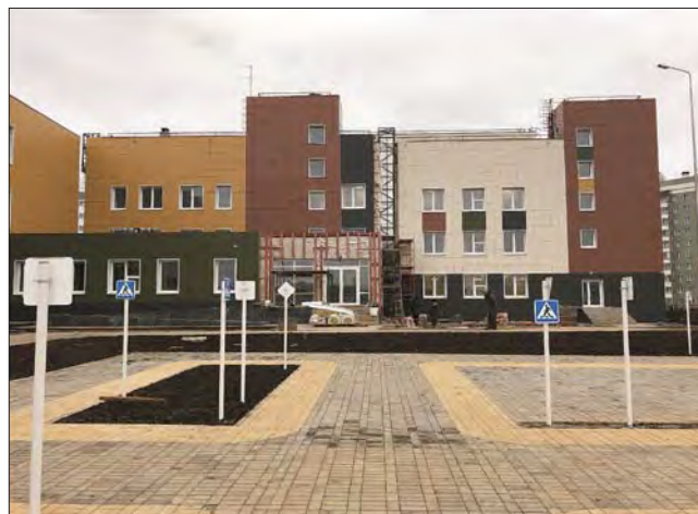
Строительство школы с бассейном на 1 тыс. учащихся выполнено с применением сборно-монолитного каркаса с пустотным настилом. Монтаж каркаса здания школы выполнен ООО «Рекон – Развитие» в течение двух месяцев 2018 г. Генподрядчик ООО «Кировспецмонтаж», 2019, г. Киров
