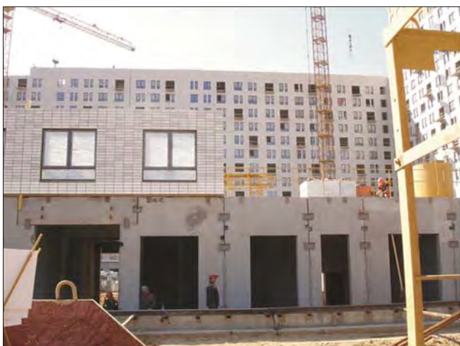
Массовая застройка жилыми домами с преднапряженными плитами перекрытий, изготовленными на универсальных стендах ЗАО «Рекон». 2018 г. ООО «НСС» (г. Обнинск) и ГК «ПИК» (г. Москва)
