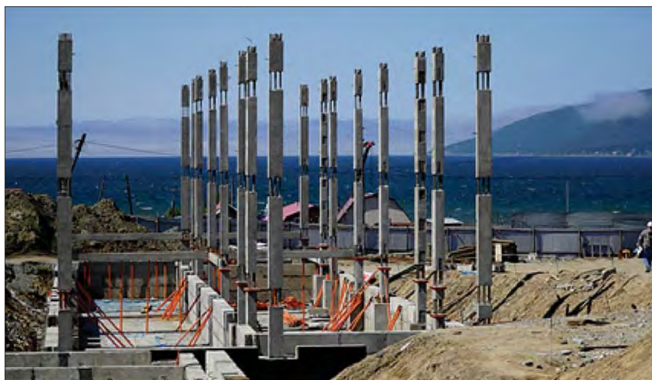
Строительство жилых домов с применением сборно-монолитного каркаса с пустотным настилом и трехслойной несущей стеной, изготовленными на универсальных стендах ЗАО «Рекон». Сейсмостойчивость 9 баллов. 2020 г. Магадан. СК «Заря» (Москва)
