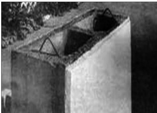
Рис. 1. Крупноразмерный двухпустотный гипсобетонный блок (1,2×0,8×0,4 м) производства треста № 3 г. Уфы в 1957–1959 гг. (1958 г.)
