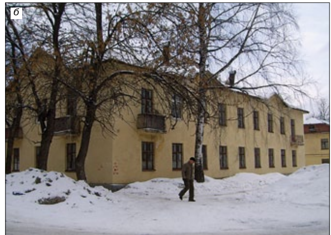
Рис. 3. Жилой дом в Уфе (ул. Калинина) с несущими стенами из гипсобетонных блоков: а – 1956 г.; б – в 2008 г. При капитальном ремонте мелко-размерные фальш-балконы заменены на стандартные с выносными монолитными железобетонными плитами.
