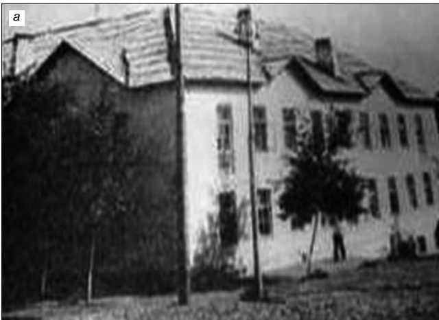
Рис. 3. Жилой дом в Уфе (ул. Калинина) с несущими стенами из гипсобетонных блоков: а – 1956 г.; б – в 2008 г. При капитальном ремонте мелко-размерные фальш-балконы заменены на стандартные с выносными монолитными железобетонными плитами.
