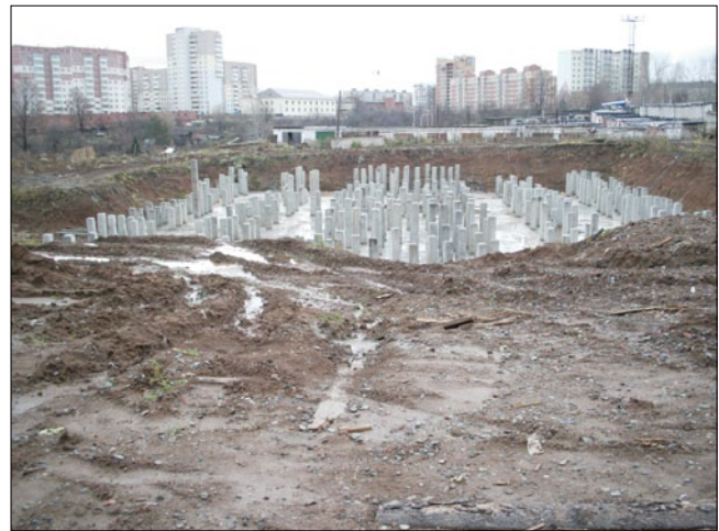
Рис. 2. Площадка опытно-промышленных испытаний забивных железобетонных свай
