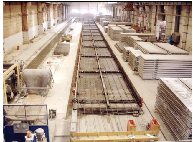
Подготовка к формированию преднапряженных дорожных плит на универсальном стенде. 2012 г. Чебоксары. ОАО «Монолитстрой»
