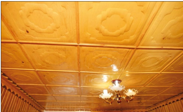
Рис. 1. Потолок помещения, облицованный рельефной фанерой
