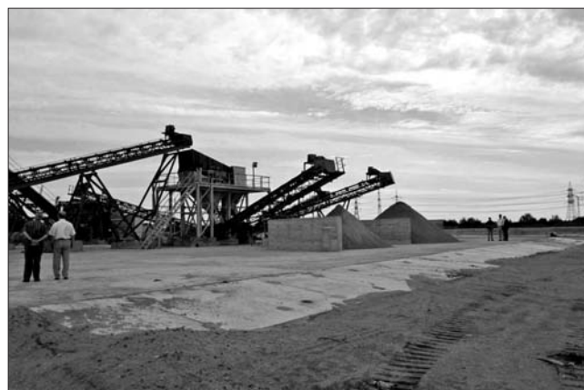
Рис. 2. Установка по производству кубовидного щебня на ОАО «ТСМ-Н»
