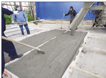
Рис. 2. Изготовление экспериментальных моделей плит перекрытий
