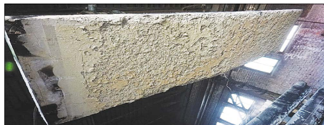
Рис. 5. Взрывообразное разрушение бетона со стороны обогреваемой бетонной поверхности плиты марки А после огневого испытания
