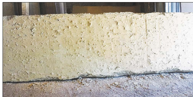
Рис. 6. Вид обогреваемой бетонной поверхности плиты марки М после испытания
