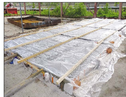
Рис. 3. Условия твердения экспериментальных моделей плит перекрытий
