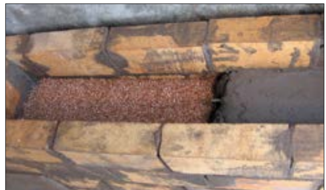
Рис. 4. Фрагмент стены, утепленной татарским вермикулитом фракции + 0,6–2 (2008 г.)
