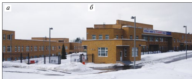
Рис. 2. Павловская гимназия (общий вид сооружения): а — начальная школа; б — Административный корпус
