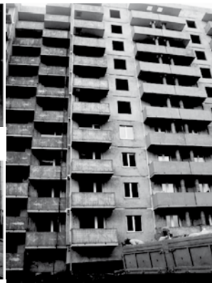
Подача пенобетонной смеси для теплоизоляции кровли 10-ти этажного дома
