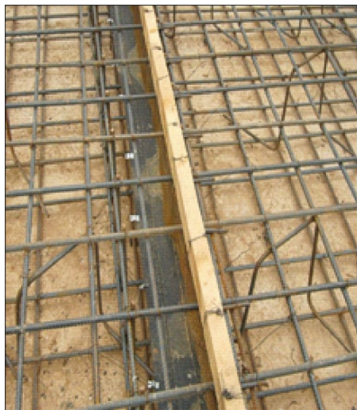
Рис. 5. Фрагмент устройства непроницаемого рабочего шва
