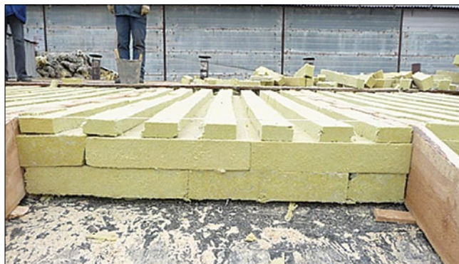
Рис. 3. Участок с полужесткими плитами утеплителя и каналами в нем для вентиляции конструкции
