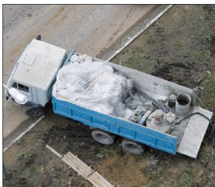
Рис. 4. Оборудование для производства и подачи пенобетонной смеси размещается в кузове грузового автомобиля. Большую часть рабочего места занимает склад вяжущих веществ и наполнителей
