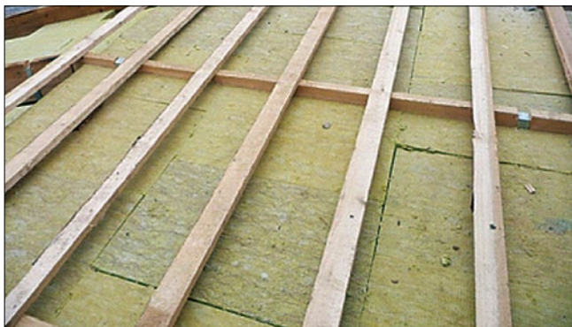
Рис. 2. Участок с полужесткими плитами утеплителя и одинаковым его площади вентиляционным пространством
