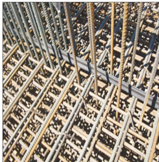
Рис. 9. Фрагмент устройства непроницаемого шва
