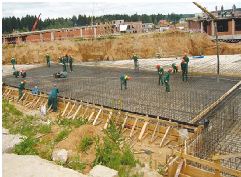
Рис. 4. Блок фундаментной плиты перед бетонированием
