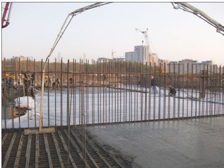
Рис. 8. Блок фундаментной плиты в процессе бетонирования
