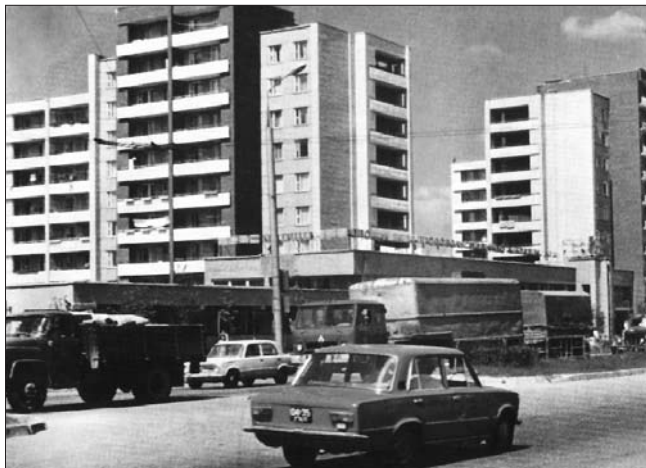
Рис. 5. Жилые дома различной этажности из плотных и пористых силикатных бетонов в Белоруссии
