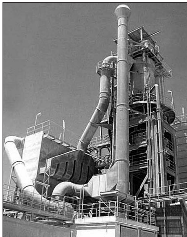
Рис. 1. Шахтная печь с контролем обжига
