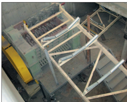
Рис. 2. Глинодробилка Verdes на стадии монтажа
