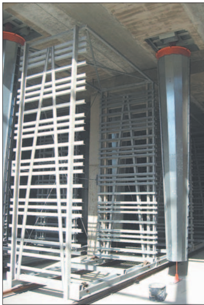
Рис. 5. Сушильные вагонетки между тубусами ротамиксеров Solinmix в сушилке Solmix (стадия монтажа сушилки)
