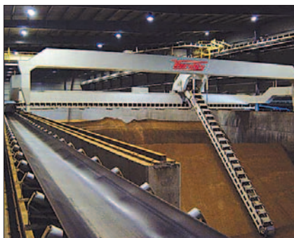
Рис. 3. Многоковшовый экскаватор Verdes
