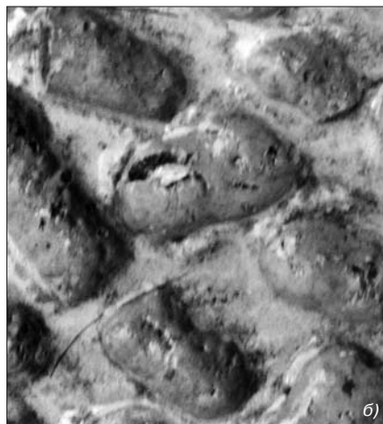
Виды отделки керамзитом: а – орнамент; б – крупноточечная неокрашенным керамзитовым гравием; в – пиленая
