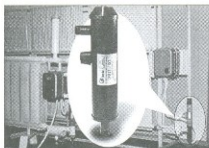
Рис. 2. Электроводонагреватель нового поколения — электродный котел проточного типа, работа которого основана на ионизации теплоносителя — фирмы «Галан»
