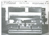
Рис. 3. Отопительный котел Майти Терм НН 3500 мощностью 840 кВт
