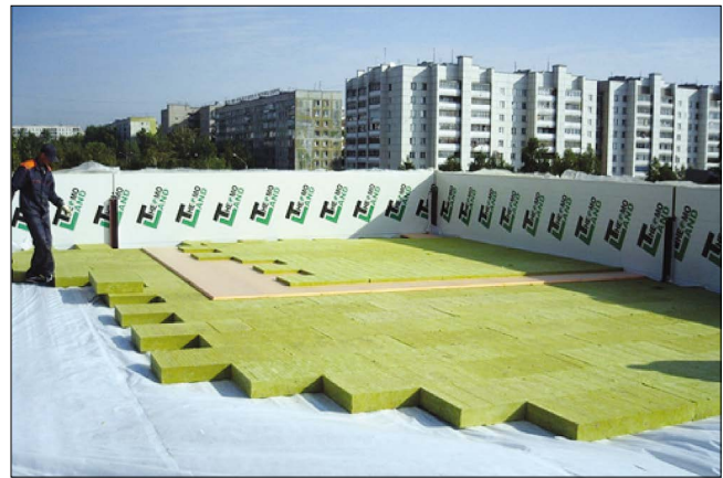
Рис. 3. Устройство теплоизоляции по подкладочному слою перед настлом полимерного кровельного покрытия из ПВХ-мембран (г. Барнаул, ТЦ «Европа»; площадь поверхности 13500 м 2 )
