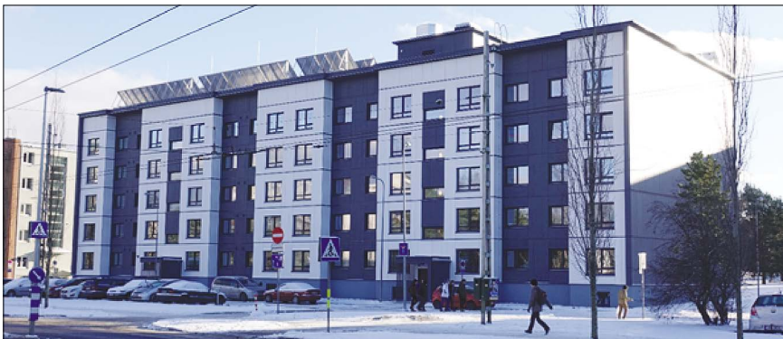
Рис. 3. Хорошо изолированные ограждающие конструкции здания с локальной выработкой энергии необходимы для пассивного дома (nZEB)
