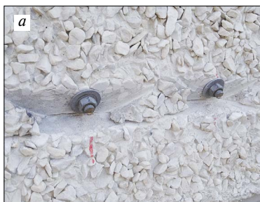
Рис. 10. Оригинальные фасады были усилены диагональными якорями (а). Модульные деревянные элементы были повешены на существующую поверхность стены с помощью разработанных фиксаций, позволяющих регулирование модулей во всех трех направлениях (b)
