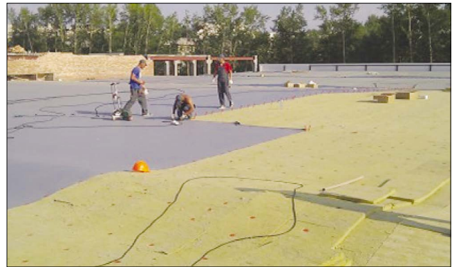
Рис. 4. Производство кровельных работ по устройству покрытия из ПВХ-мембраны в период монтажа (г. Омск, торговый центр; площадь поверхности 17200 м 2 )
