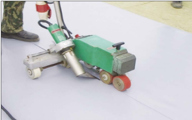
Рис. 2. Работа сварочного аппарата горячего воздуха Leister Varimat V2 (Варимат), используемого для сварки внахлест кровельных покрытий из ПВХ-мембран при движении «на себя»
