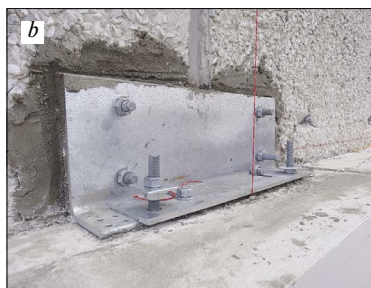
Рис. 10. Оригинальные фасады были усилены диагональными якорями (а). Модульные деревянные элементы были повешены на существующую поверхность стены с помощью разработанных фиксаций, позволяющих регулирование модулей во всех трех направлениях (b)
