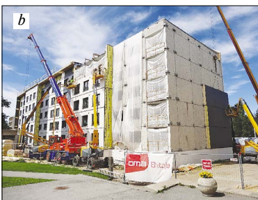
Рис. 9. Деревянные элементы монтировались непосредственно с грузовика одно- временно на два фасада (а). Для минимизации влияния дождя облицовываемые фасады были влагоизолированы (b)
