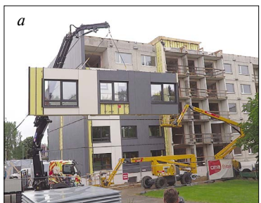
Рис. 9. Деревянные элементы монтировались непосредственно с грузовика одно- временно на два фасада (а). Для минимизации влияния дождя облицовываемые фасады были влагоизолированы (b)
