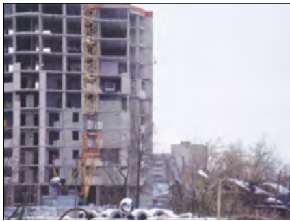
Рис. 5. Возведение многоэтажного жилого дома из полистиролбетона
