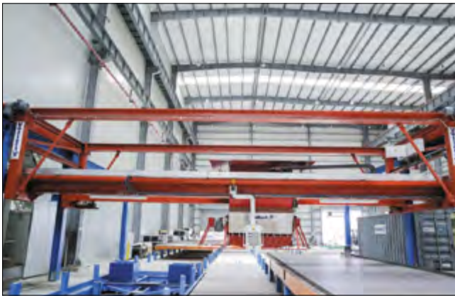
Точная подача бетона благодаря современному автоматическому бетонораздатчику SMART CAST
