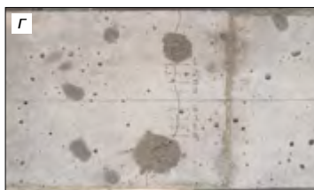
Рис. 2. Формирование трещины: а – схема изгибающего механизма; б – общий вид изгибающего механизма; в – создание отверстий вдоль трещины; г – зачеканивание отверстий цементным раствором для фиксации трещины
