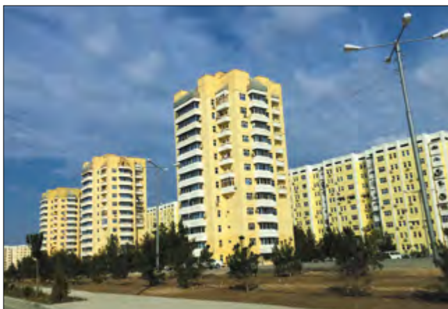
С помощью государственных программ стимулируется строительство доступного и современного жилья в Туркменистане. При этом важная роль отводится технологиям строительства из сборных железобетонных элементов
