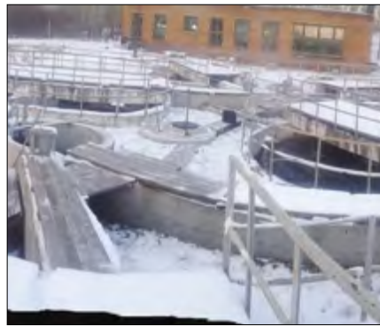
Рис. 9. Вторичные отстойники очистных сооружений УВИК Филиала ФГУП «НПО «Микроген» Минздрава России в Томске
