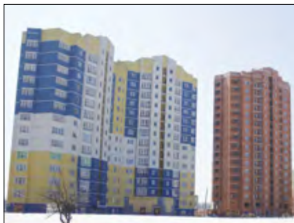
Рис. 6. Жилые монолитные дома с ограждающими конструкциями из полистиролбетонных блоков
