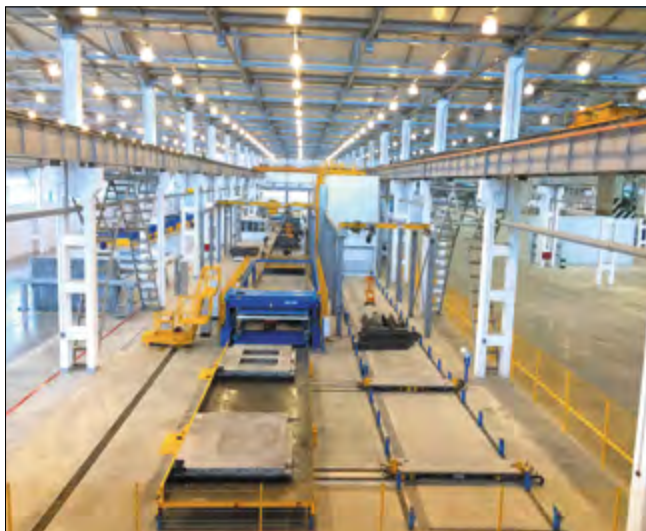
На двух линиях циркуляции паллет ашхабадского завода производятся стеновые массивные панели и сэндвич-панели
