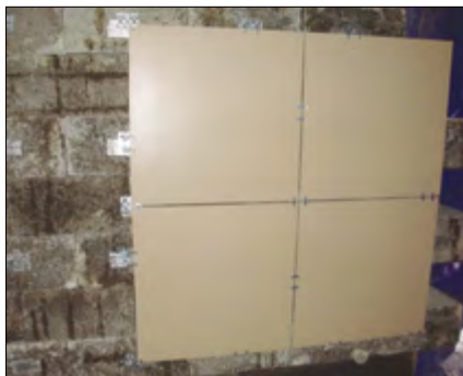
Рис. 9. Полистиролбетонные блоки с закладными деталями при креплении облицовки
