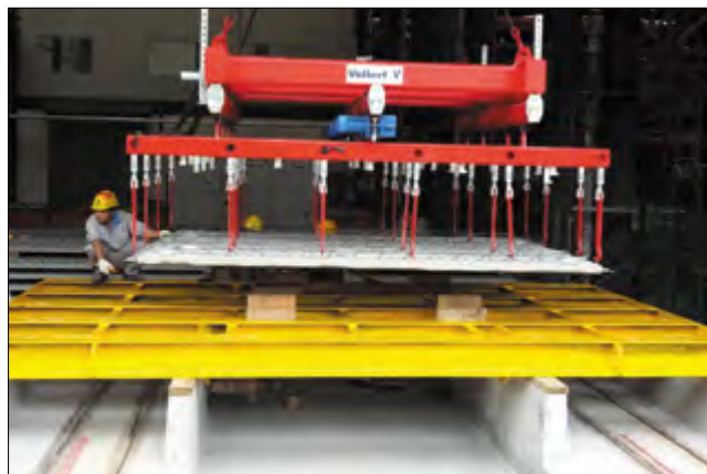
Элементы перекрытий укладываются при помощи подъемной установки горизонтально в штабели для перевозки
