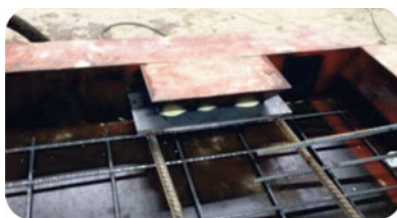
Фиксация металлической закладной после нанесения CASTTEC-клея.
