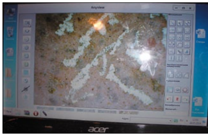
Рис. 3. Результаты съемки состояния покрытия надземного мостового пешеходного перехода
