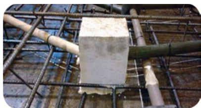
Фиксация элементов электро-разводки.
