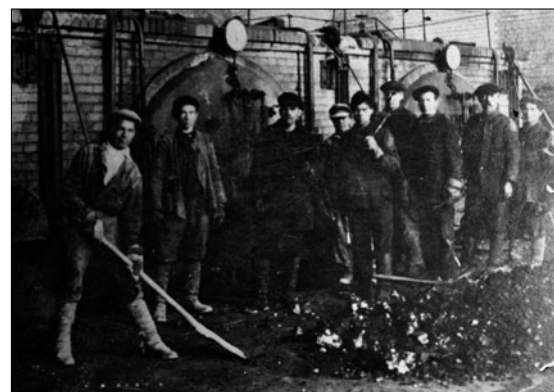
Завод 30-х гг., парокотельный цех. Так выглядел Дзержинский завод силикатного кирпича в начале 1930-х гг. Первый парокотельный цех, уголь загружается в топи лопатами вручную
