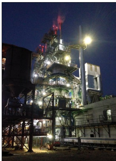
Печи «Мерц» – сердце завода по производству извести
