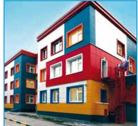
Детский сад, построенный с использованием пустотных плит перекрытия
