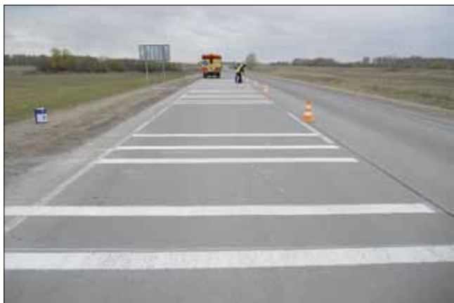
Рис. 3. СПИ 2009–2011 гг. на автомобильной дороге М-51 «Байкал» в Новосибирской области, участок с цементобетонным покрытием
