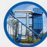
Обеспыливающее оборудование (циклоны, рукавные фильтры)
