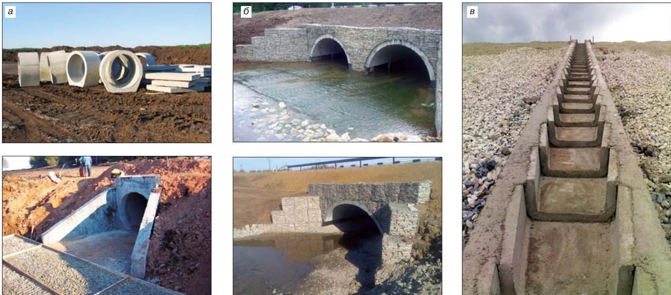
Рис. 6. Применение сталефибробетонных водопропускных труб (а), малопролетных засыпных арочных мостов (б), телескопических водосборных лотков (в) на объектах дорожного строительства Республики Башкортостан
