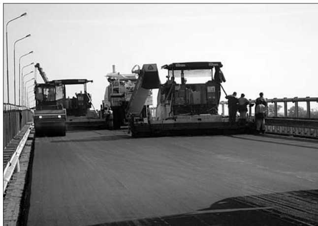
Рис. 1. Укладка полимерасфальтобетона на проезжей части моста через реку Уфа
