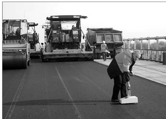
Рис. 2. Экспресс-метод контроля степени уплотнения полимерасфальтобетонного покрытия
