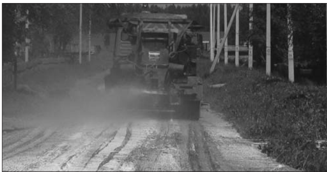
Рис. 4. Обеспыливание грунтовых дорог
