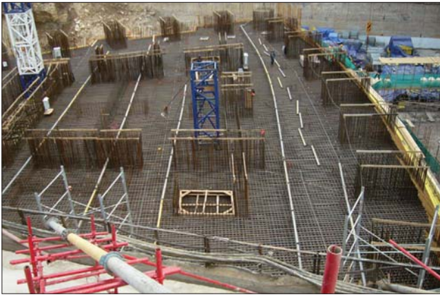
Рис. 3. Общий вид ростервка башни «А» комплекса «Федерация». Армирование
