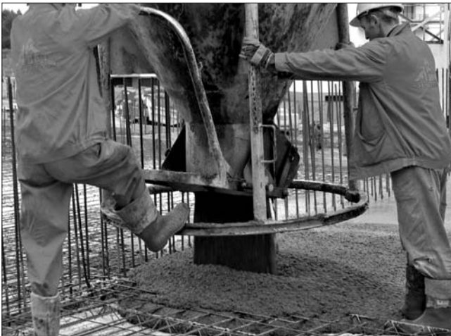
Рис. 1. Заливка бетонного раствора перекрытий
