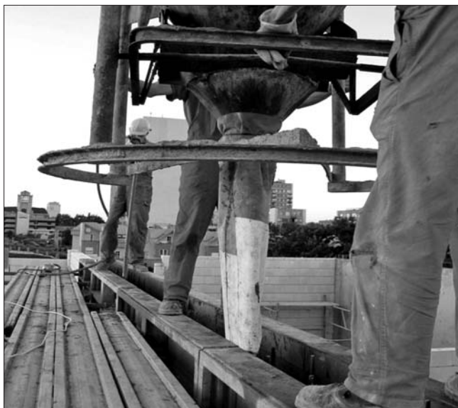
Рис. 2. Бетонирование стен
