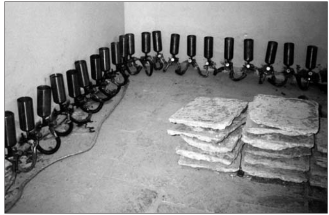
Возобновление горизонтальной изоляции парафиновым методом W-ART
