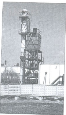
Рис. 3. Цех по производству ячеистого бетона «Мосастермостекло» (г. Железнодорожный Московской обл.)
