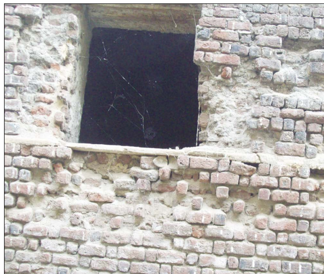
Рис. 4. Дом El Manadily. Постоянная деформация кирпича в зоне границ и главная стена фасада
