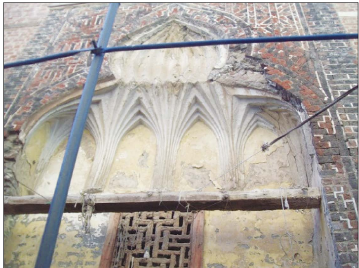
Рис. 1. Повреждения из-за повышенной влажности Fig. 1. Deterioration due to rising humidity
