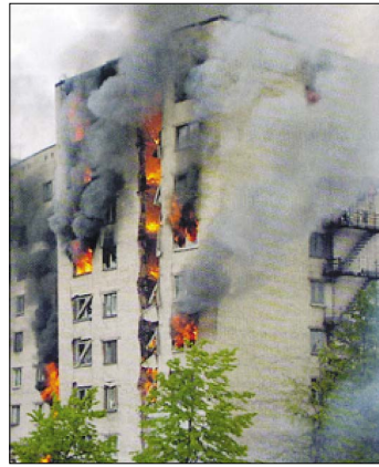
Рис. 2. Объемный пожар в жилом доме
