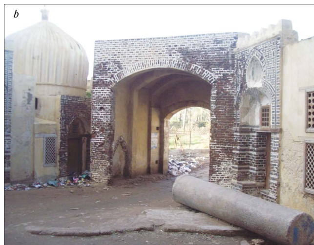
Рис. 5. Главный фасад bawabet Abo el Riesh (a); опасности трещины появились в некоторых колоннах и разделение между фасадом и радиальными стенками (b)
