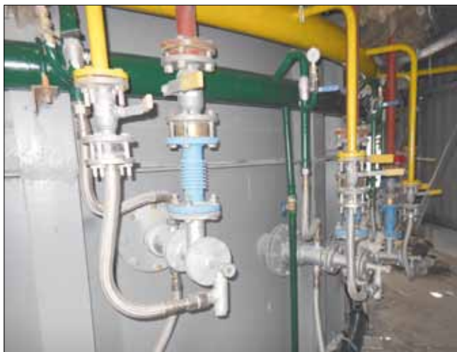
Рис. 5. Установка периферийных фурм снаружи корпуса действующей кольцевой печи
