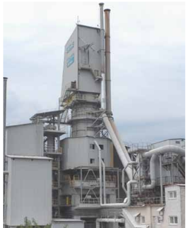
Рис. 3. Действующая шахтная кольцевая печь на ОАО «Ашинский металлургический завод»
