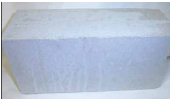
Рис. 9. Следы от конденсата и растворенной извести на поверхности кирпича
