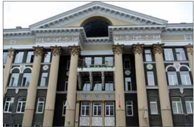
Изначально здание Управления Восточно-Сибирской железной дороги, построенное по проекту К.В. Миталья в 1930-х гг., являлось типичным для конструктивистской архитектуры. Однако в конце 1940-х – начале 1950-х гг. архитектор Д.М. Гольштейн при реконструкции полностью перестроил здание в соответствии со сталинским классицизмом
