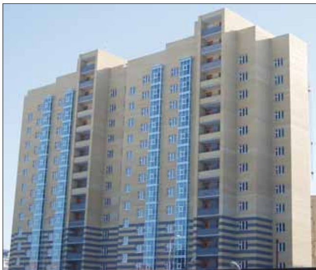
Современный жилой дом из силикатного кирпича
