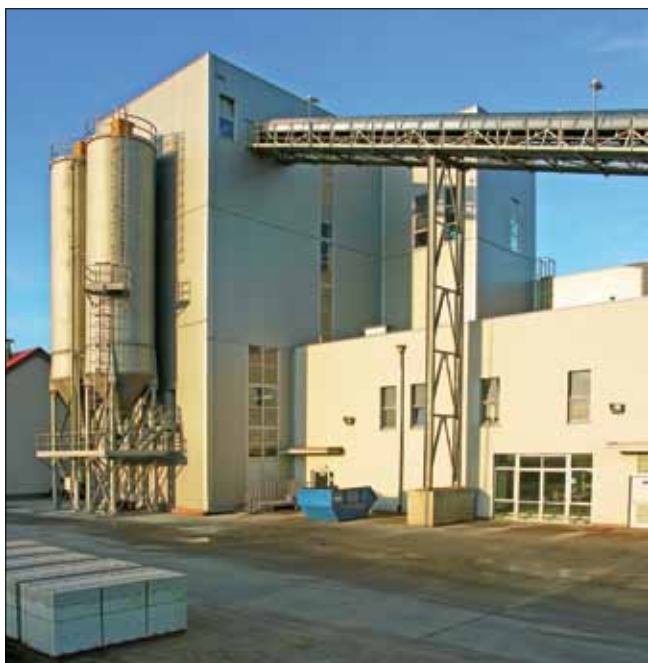
Рис. 3. После автоматического просеивания песок по транспортерам подается в бункеры над смесительной установкой. Силосы извести, расположенные вне производственных помещений, делают возможным хранение двух различных сортов извести
