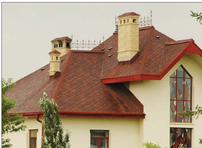
Рис. 1. Здание с кровлей из битумной черепицы
