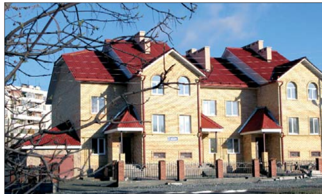
Рис. 4. Здание с кровлей из хризотилцементного шифера
