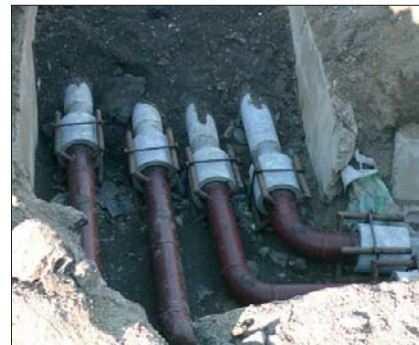
Рис. 6. Бесканальная прокладка четырехтрубной теплотрассы с упрощенной (засыпной) теплоизоляцией (с. Сосновка, Челябинск): а – общий вид перед гидроиспытаниями; б – поворот теплотрассы перед заливкой бетоном
