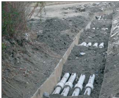
Рис. 6. Бесканальная прокладка четырехтрубной теплотрассы с упрощенной (засыпной) теплоизоляцией (с. Сосновка, Челябинск): а – общий вид перед гидроиспытаниями; б – поворот теплотрассы перед заливкой бетоном
