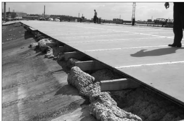
Рис. 4. Монтаж кровельной системы «Урал-3» на крыше промышленного здания
