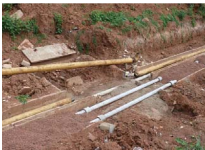
Рис. 7. Тепловая сеть из хризотилцементных труб с засыпной керамзитовой теплоизоляцией (г. Ижевск, ул. 40 лет Победы)
