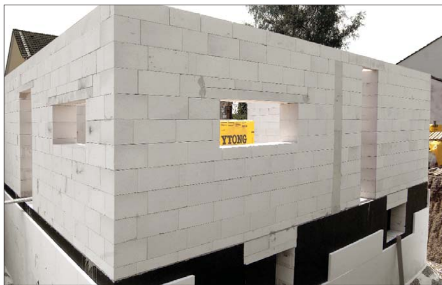
Рис. 4. Пример возведения энергоэффективных стен здания из ячеистого бетона YTONG®, г. Эссен (Германия)
