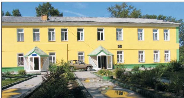
При ремонте здания заводоуправления максимально использована продукция ЗАО «Искитимский шиферный завод»
