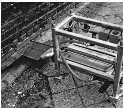
Рис. 2. Восстановление изоляции методом HV
