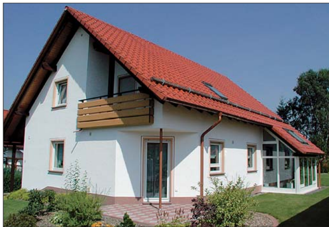
Загородный дом, оштукатуренный с использованием сухой смеси Кнауф Коттеджная сохранит первозданный вид на много лет
