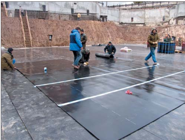
При строительстве здания на ул. Русаковской маты Sylomer® (черного цвета) укладывались на горизонтальное бетонное основание в два слоя. Стыки матов соединены скотчем
