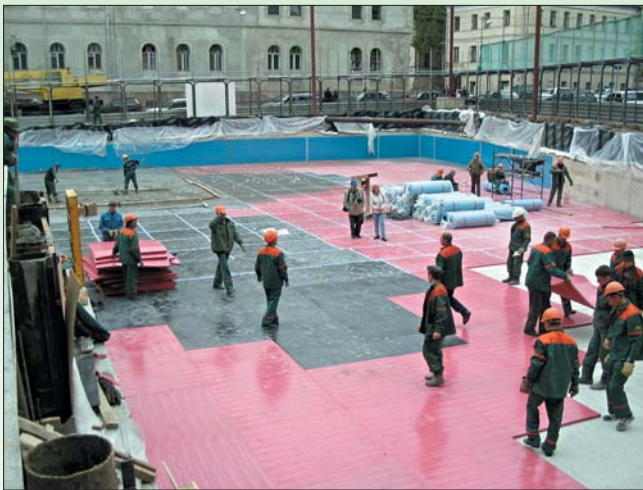
Виброизоляция жилого здания на 1-м Колобовском пер. выполнена на горизонтальных (черный и красный Sylomer®) и вертикальных (синий Sylomer®) поверхностях. На вертикальные поверхности материал приклеен к бетону двухкомпонентным клеем
