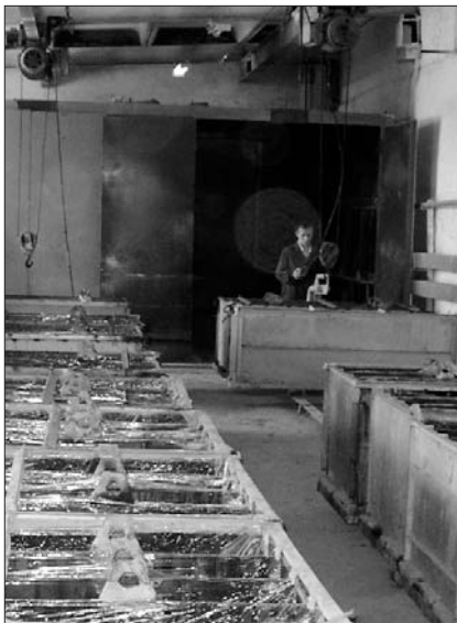
Рис. 6. Установка залитых форм в термокамеру на первой линии, на второй линии формы подготовлены к заливке
