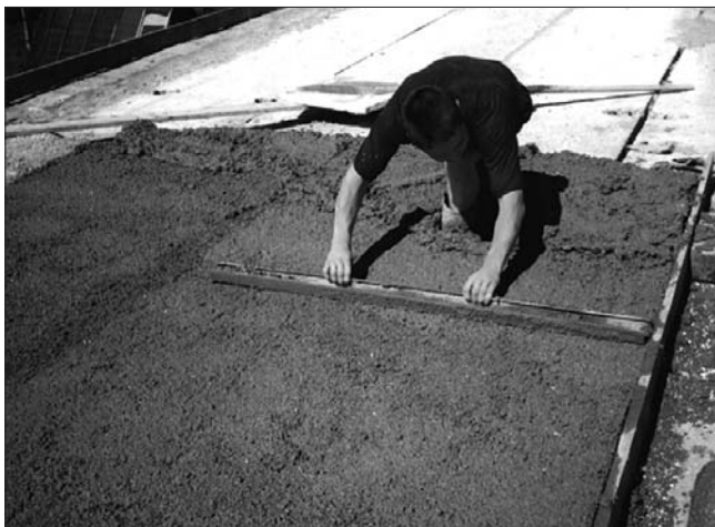
После нанесения на поверхность «Политерм» разравнивают
