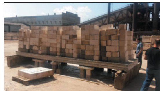
Рис. 9. Натурные испытания опытной плиты перекрытия на действие разрушающих нагрузок. Выполнено на производственной базе ООО «Уфимская гипсовая компания»
