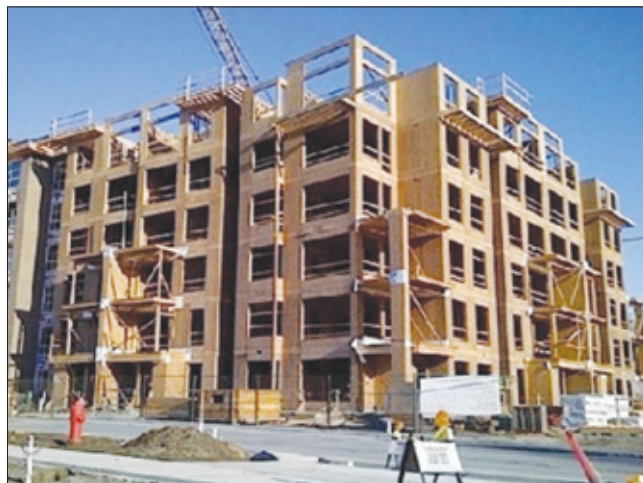
Рис. 4. Экспериментальное строительство многоэтажных деревянных жилых домов в Москве
