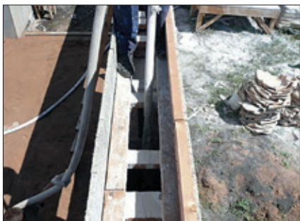
Рис. 5. Заполнение монолитным пеногипсом наружных стен
