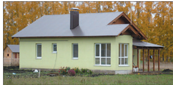
Рис. 3. Одноквартирный жилой дом в п. Иглино с деревянным каркасом и заполнением наружных стен монолитным пеногипсом
