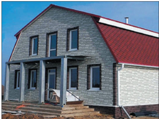
Рис. 1. Малоэтажный каркасный дом на основе ЛСТК
