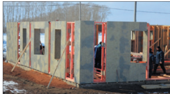
Рис. 4. Сборка деревянного каркаса с обшивкой наружной и внутренней поверхностей стен фибролитовыми плитами
