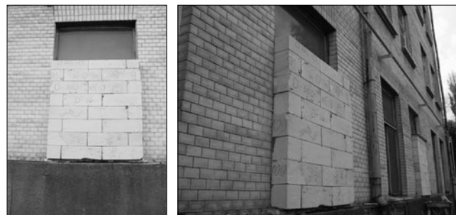
Рис. 2. Исследуемые фрагменты кладки
