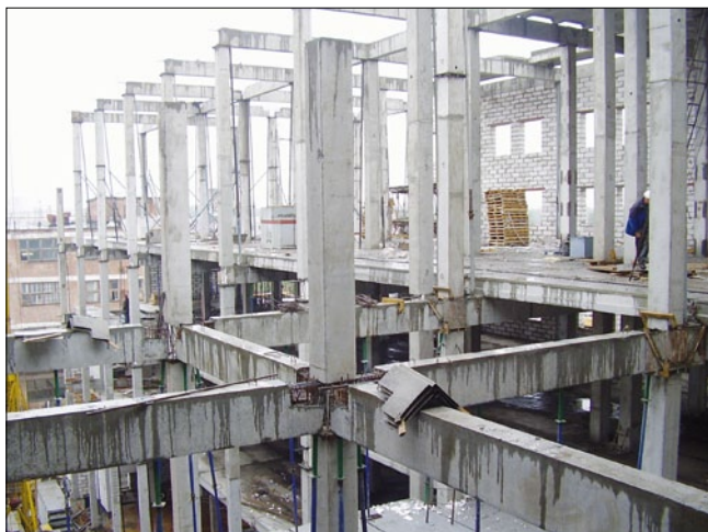
Рис. 2. Сборно-монолитный несущий каркас колонно-ригельной системы типа Saret из керамзитобетона классов по прочности на сжатие В22,5 – В40, марок по средней плотности D1650–D1850 на высокопрочном керамзите ООО «Новочебоксарский ДСК» для возведения каркасно-панельного здания (г. Новочебоксарск, 2005)
