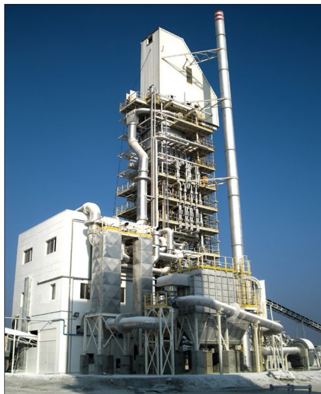
Рис. 1. Шахтная печь Terruzzi Fercalx (2006 г.) мощностью 200 т/сут
