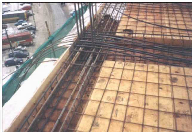
Рис. 5. Подготовленное к бетонированию предварительно напряженное перекрытие из керамзитобетона класса В 27,5 с натяжением арматуры в построечных условиях (при двухэтажной надстройке 5-этажных зданий в Москве)
