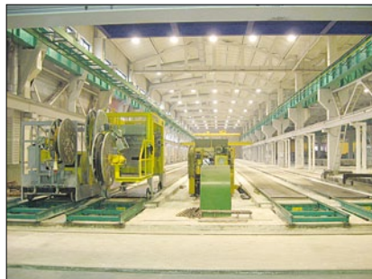
Рис. 1. Технологическая линия формования на «длинных» стендах Новочебоксарского ДСК предварительно напряженных плит перекрытий из керамзитобетона класса по прочности В30 для несущего сборномонолитного каркаса жилых зданий. 2004 г.
