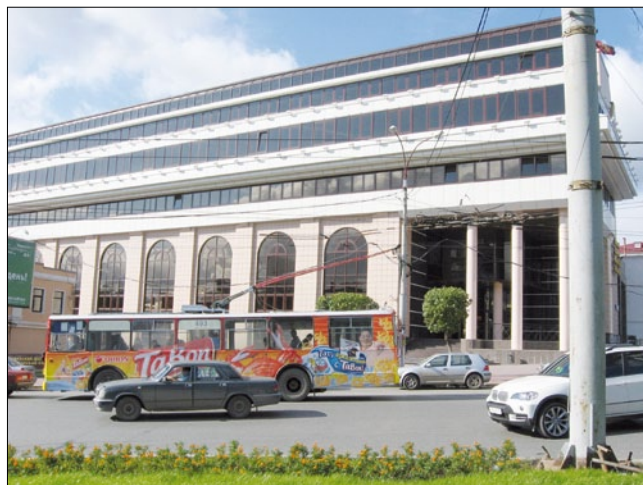
Рис. 3. Семизэтажный деловой центр в Екатеринбурге, ул. Малышева, с несущим каркасом типа Saret из керамзитобетона (2005 г.)
