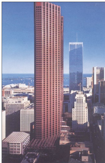
Рис. 9. Здание Scotia Plaza Tower (69 этажей, 276 м), Канада. Перекрытия выполнены из легкого бетона класса В20–В30 на основе пористого гравия с остеклованной оболочкой, полученного из доменных шлаков текущего выхода металлургического комбината «Steelko» (г. Хамильтон, штат Торонто, Канада), с использованием шлаковых цементов (типа «blended cements»-ASTM), 1990 г.
