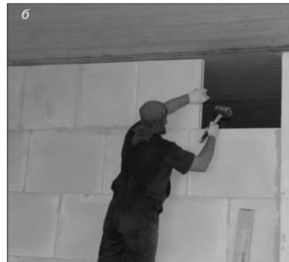
Рис. 5. Монтаж перегородки из пазогребневых блоков: а – начало; б – окончание
