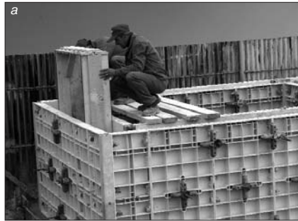
Рис. 5. Установка сборно-разборной модульной опалубки первого яруса (а); второго яруса (б)
