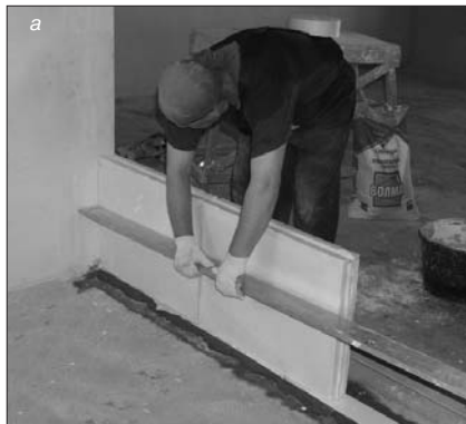
Рис. 5. Монтаж перегородки из пазогребневых блоков: а – начало; б – окончание
