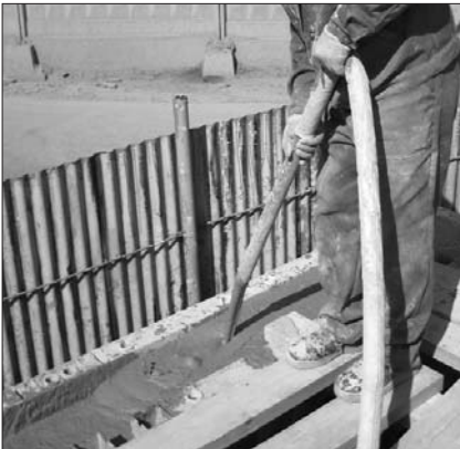
Рис. 6. Укладка гипсопоробетона в сборно-разборную модульную опалубку второго яруса
