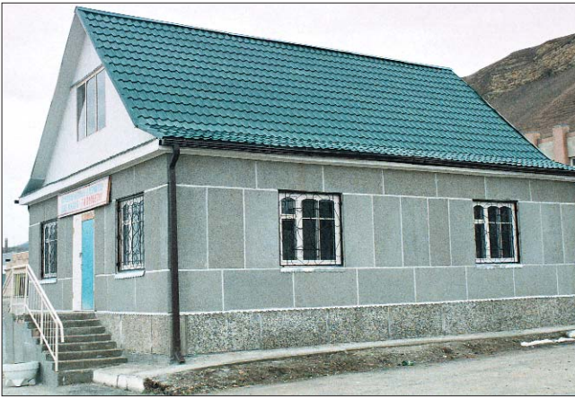
Рис. 3. Здание с мансардой со стенами из декоративно-облицовочных блоков
