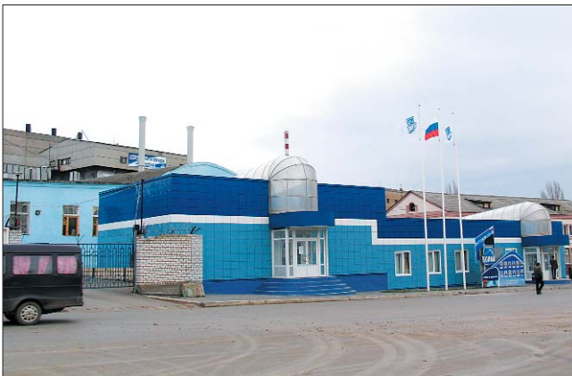
Главная проходная Волгоградского гипсового завода «ВОЛМА». На втором плане старые производственные корпуса
