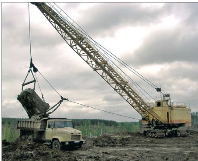
Погрузка вскрышных пород гусеничным драглайном ЭДГ-3,2.30А на Полдневском карьере ОАО «Огнеупоры».
