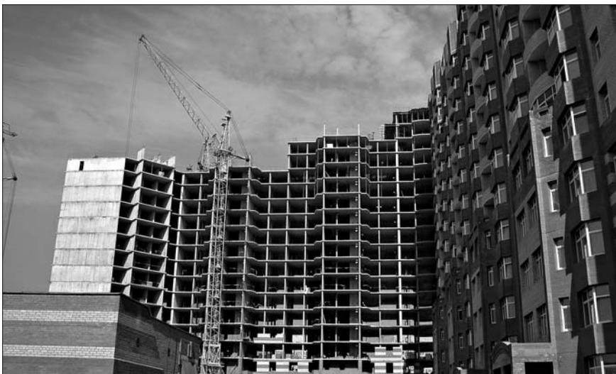
Десятиподъездный дом «Былина» представляет собой монолитный каркас с кирпичными ограждениями и облицовкой
